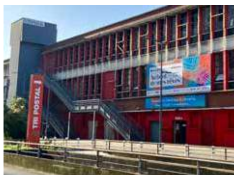
Façade du Tripostal, Lille
